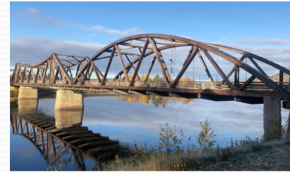
Flisa bru ble åpnet i 2005. Foto: Statens vegvesen.
