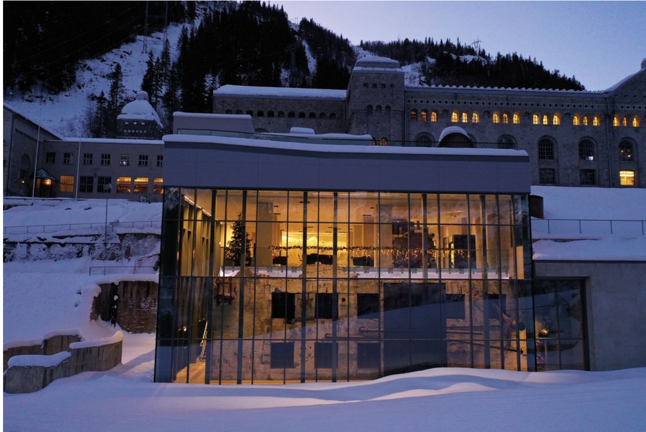
Foto: A til Å Entreprenør
