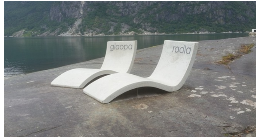
Elementer i GRC med relieff og innfyll farger
