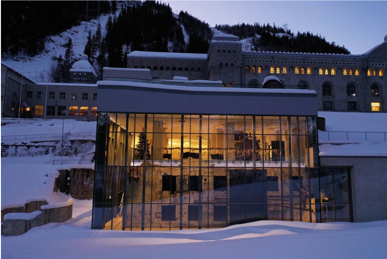
Foto: A til Å Entreprenør
